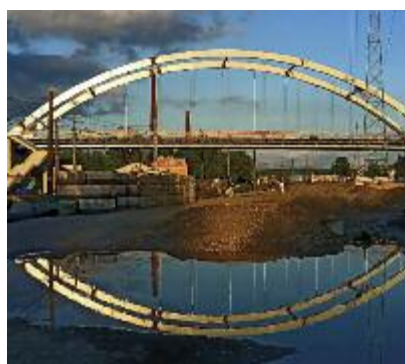
Już dziś wiadukt robi wrażenie.
